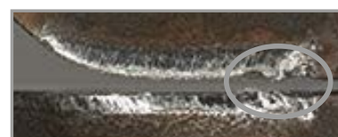
Filo de corte dañado
